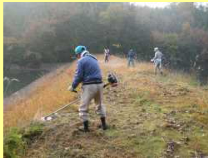
ため池堤防草刈
